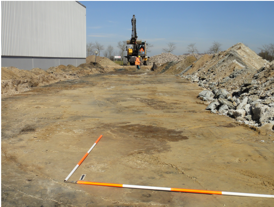
Afbeelding 2.2. Fundering van een silo, werkput 2 spoor 18. Foto: A. Ufkes.
