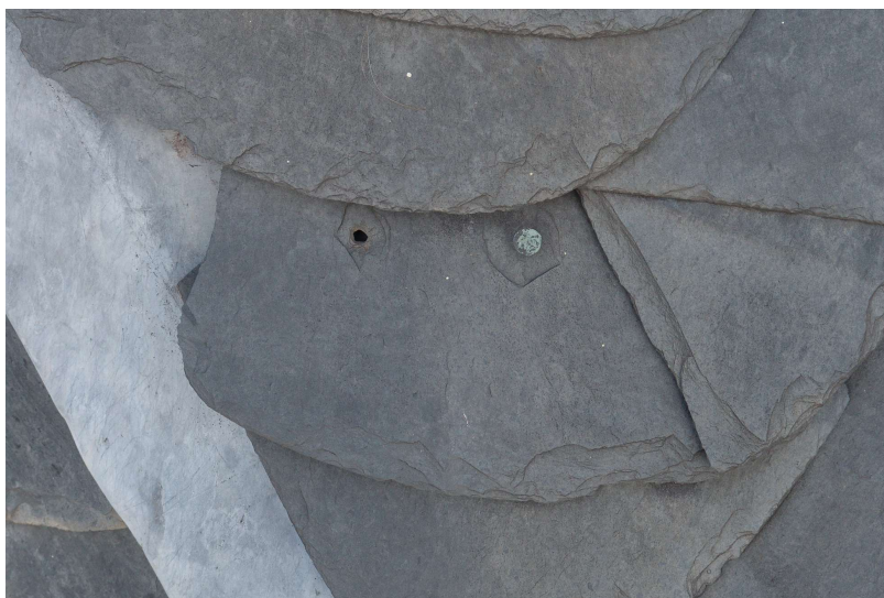
Afbeelding 7.1. Bevestiging van leisteen-dakpannen door middel van nagels op een kerktoren. Foto: J.R. Veldhuis.
