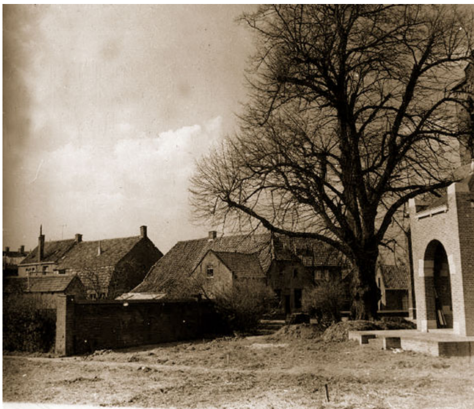
Afbeelding 2.3 Foto van de muur aan de zuidzijde van de kerk. Foto: www.leovanschijndel.nl .
