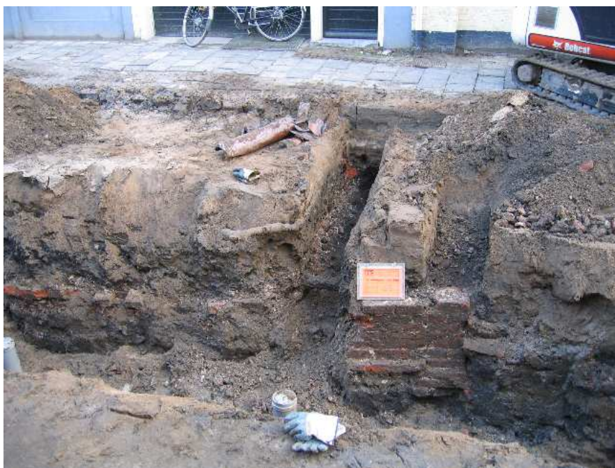
Afbeelding 2.19 Herebinnensingel. De noordwesthoek van de in de sleuf vastgelegde fundering. Foto A. Wieringa.
