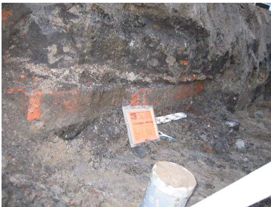
Afbeelding 2.21 Herebinnensingel. Zogenaamde molgoot of riepe, twee rijen op hun kant geplaatste bakstenen. Foto A. Wieringa.
